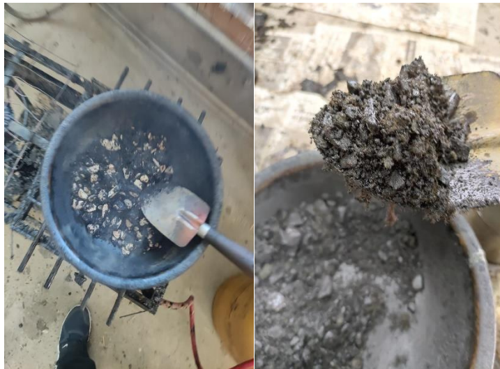
Figura 50. Mezclado de los agregados con el cemento asfáltico y las fibras de poliolefina para la elaboración de la mezcla asfáltica modificada
