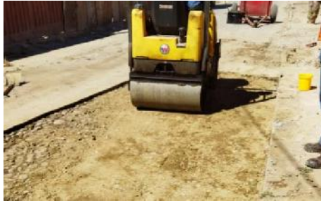
Figura 3. 38 Compactado del área aplicada.
