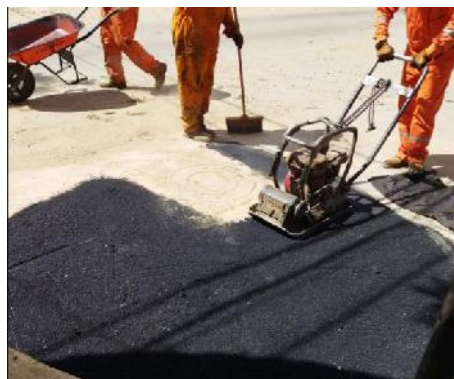
Figura 3. 92 Compactado y limpieza.
