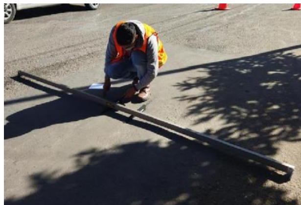
Figura 4. 4 Colocado de la regla sobre el bache.
