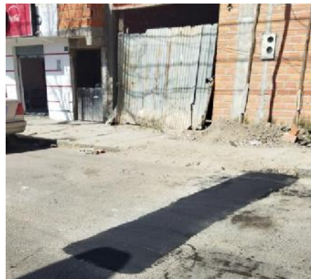
Figura 3. 80 Mezcla aplicada en acometida.
