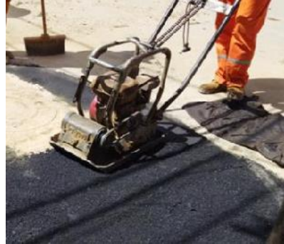
Figura 3. 82 Compactación y limpieza del área.
