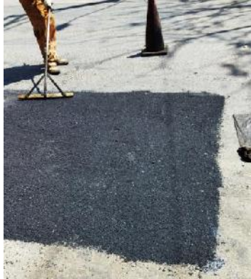
Figura 3. 127 Aplicación y compactado en la zona.
