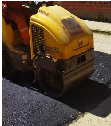
Figura 2. 6 Compactado de la mezcla.
