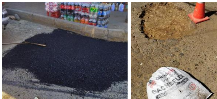
Figura 3. 32 Aplicado de la mezcla asfáltica.
