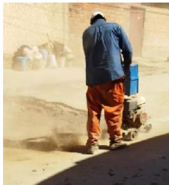
Figura 2. 2 Perfilado del área a reparar.
