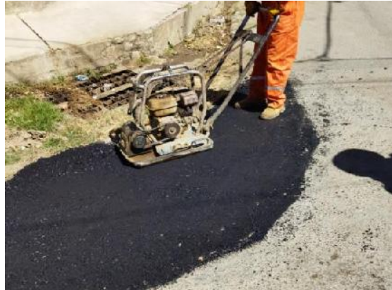
Figura 3. 123 Aplicación, compactación y limpieza.
