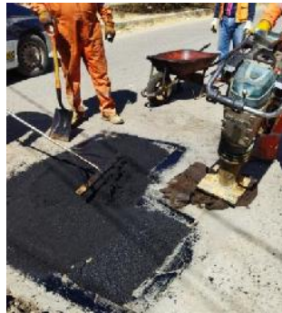
Figura 3. 49 Compactado y limpieza del área.
