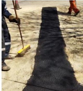
Figura 3. 95 Limpieza del área.
