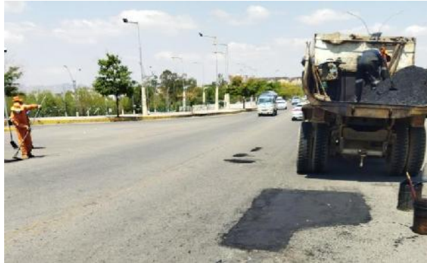
Figura 3. 103 Aplicación y compactado.
