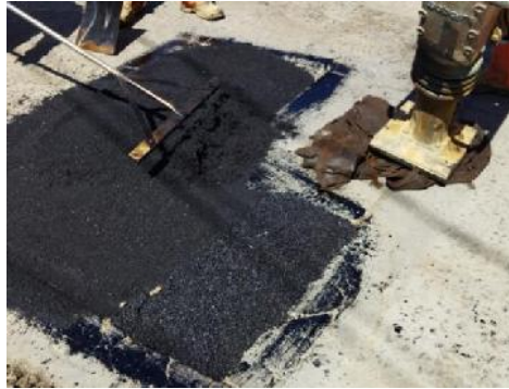
Figura 2. 5 Aplicación de la mezcla asfáltica.
