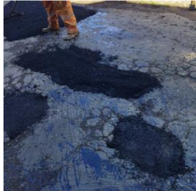
Figura 3. 125 Aplicación y compactación de la mezcla.
