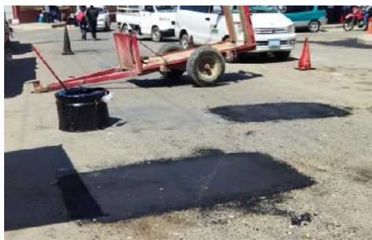
Figura 3. 89 Limpieza del área reparada.
