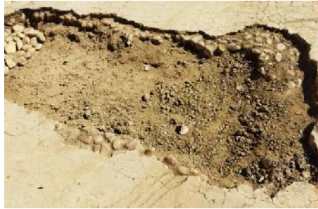
Figura 3. 35 Identificación del área a refaccionar.
