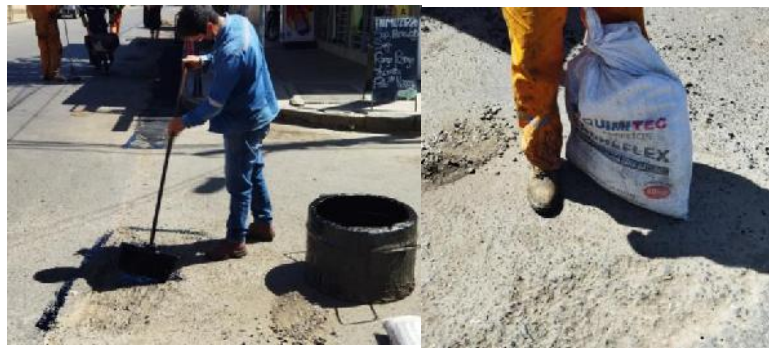
Figura 3. 81 Aplicación del producto.
