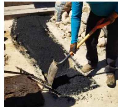
Figura 3. 65 Aplicación de la mezcla asfáltica.
