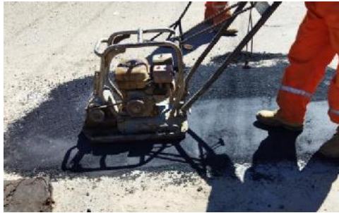
Figura 3. 59 Compactado de la mezcla asfáltica.
