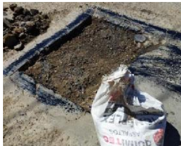
Figura 3. 47 Aplicación del ligante.
