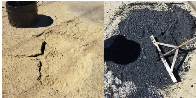
Figura 3. 115 Limpieza y aplicado del producto.
