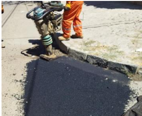
Figura 3. 78 Compactado y limpieza de residuos.
