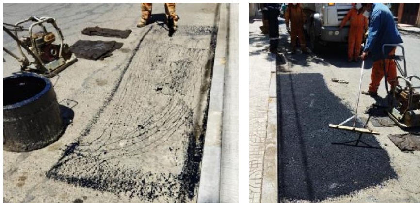
Figura 3. 118 Limpieza y aplicado de la mezcla.
