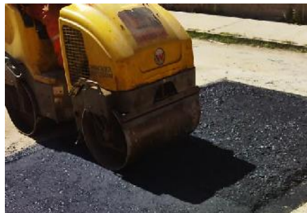
Figura 3. 40 Compactado con rodillo.
