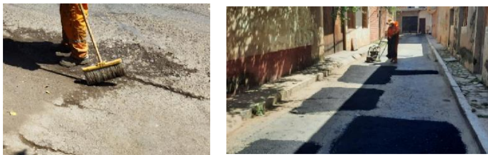
Figura 3. 105 Aplicación, nivelado y compactado de la mezcla.
