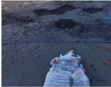
Figura 3. 121 Limpieza y aplicación de mezcla asfáltica.
