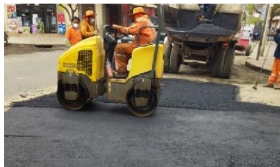
Figura 3. 98 Compactado sobre el área reparada.
