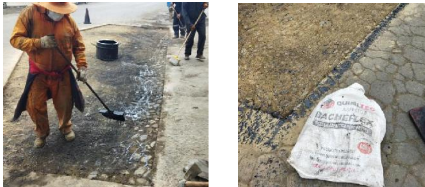
Figura 3. 97 Limpieza y aplicado del producto.
