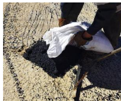
Figura 3. 57 Aplicado de la mezcla asfáltica.
