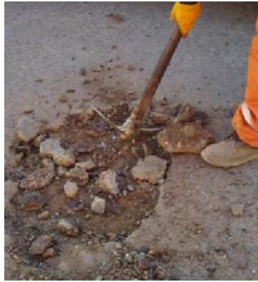
Figura 2. 3 Retirado de material afectado.
