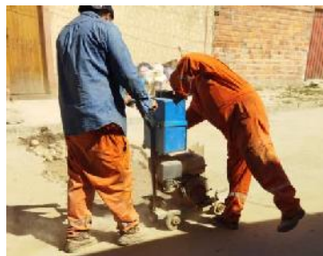
Figura 3. 37 Perfilado y encuadrado del área a reparar.
