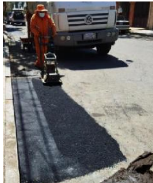
Figura 3. 119 Compactado de la mezcla asfáltica.
