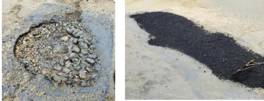
Figura 3. 100 Limpieza y aplicado de la mezcla.
