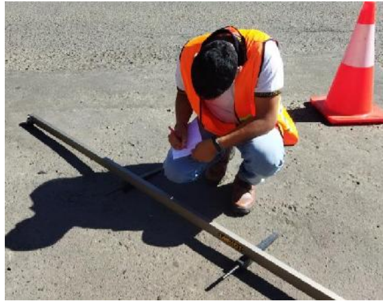
Figura 4. 5 Lectura de las mediciones de asentamiento.
