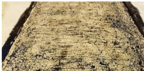
Figura 3. 39 Riego de liga antes de aplicar la mezcla asfáltica.
