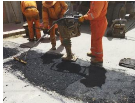
Figura 3. 74 Compactado de la mezcla.
