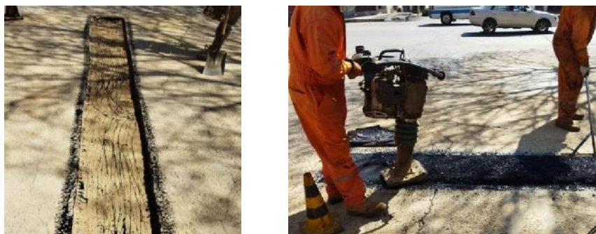
Figura 3. 84 Identificación de la falla y aplicación del producto.
