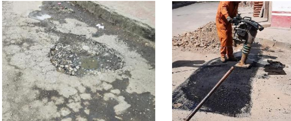
Figura 3. 110 Ubicación del bache y reparación del mismo.
