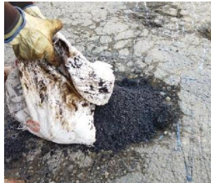
Figura 3. 76 Aplicación de la mezcla asfáltica.
