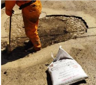
Figura 3. 70 Aplicación de la mezcla asfáltica.
