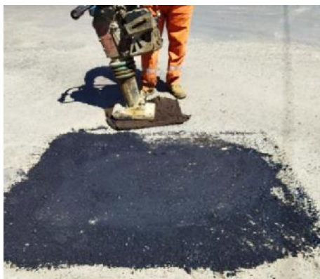
Figura 3. 116 Compactado del área reparada.
