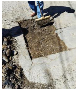
Figura 3. 46 Limpieza y recuadre de la zona.
