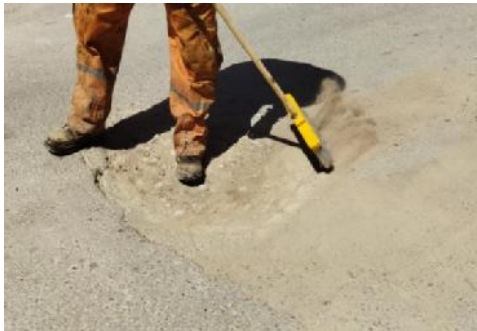
Figura 3. 73 Limpieza del área a reparar.
