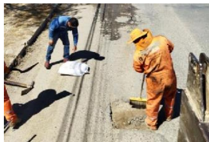
Figura 3. 52 Aplicación de la mezcla asfáltica y limpieza de la zona.
