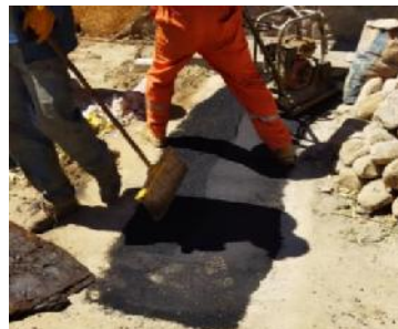
Figura 3. 67 Compactación y limpieza.
