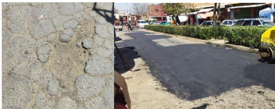
Figura 3. 88 Limpieza y aplicado de la mezcla asfáltica.
