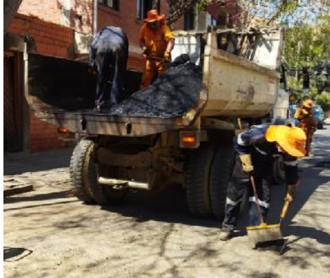
Figura 3. 86 Limpieza después de su reparación.
