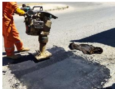
Figura 3. 54 Compactado y limpieza del ÁREA.
