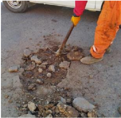
Figura 3. 26 Limpieza del área a ser reparada.
