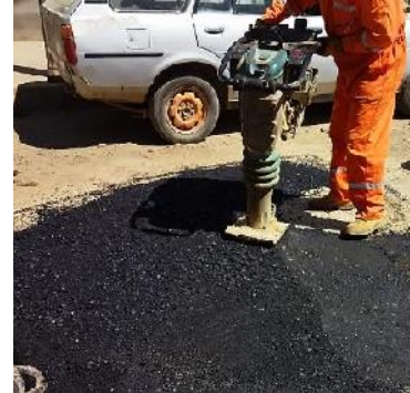
Figura 3. 71 Compactado de la mezcla aplicada.
