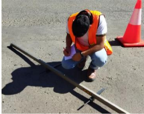
Figura 2. 19 Lectura de las mediciones de asentamiento.
