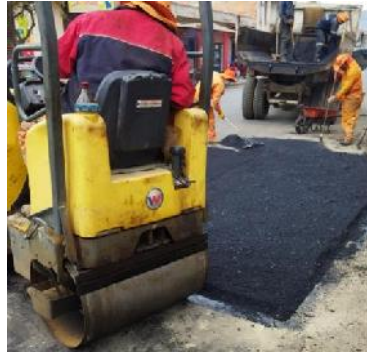
Figura 3. 101 Compactado del área.
