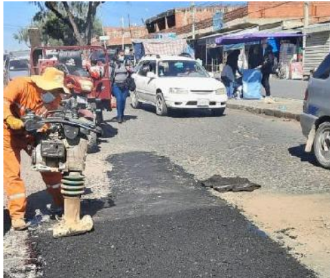
Figura 3. 107 Aplicado del producto en la zona.
