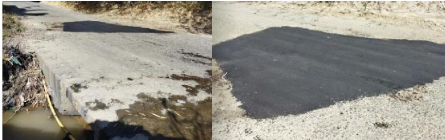
Figura 3. 113 Aplicación y compactado de la mezcla asfáltica.
