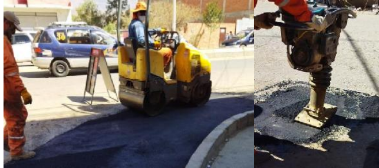
Figura 3. 33 Compactado con rodillo y motoniveladora.
