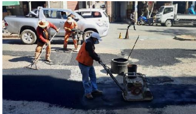
Figura 3. 108 Compactado y limpieza del área.
