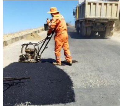
Figura 3. 62 Aplicación y compactado.
