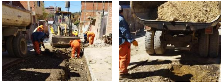
Figura 3. 36 Rellenado de la zona con material para capa base.
