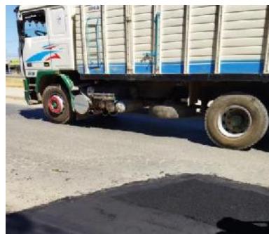
Figura 3. 55 Habilitación del tráfico inmediatamente.
