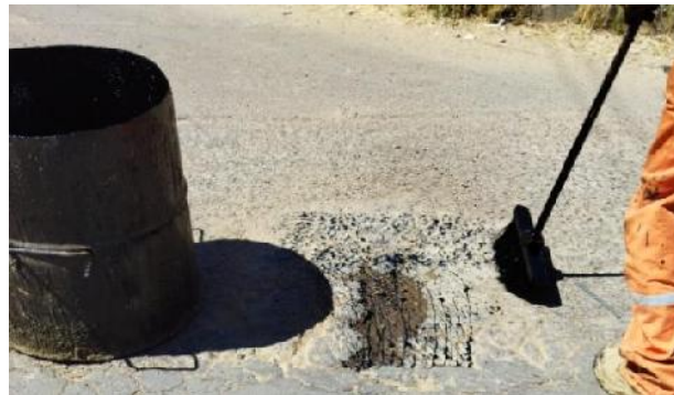
Figura 2. 4 Riego de liga previamente al bacheo.
