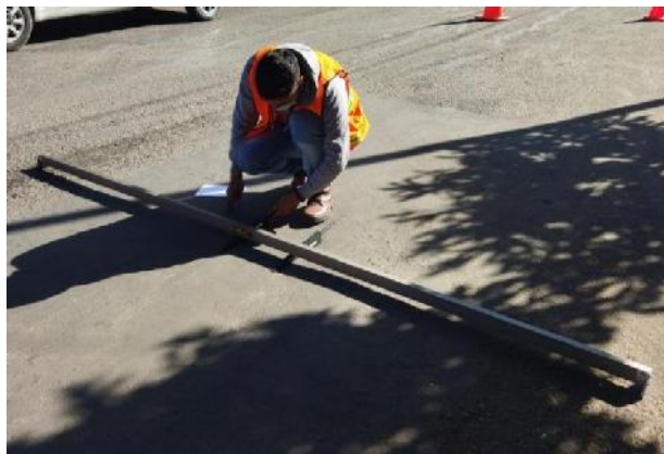
Figura 2. 18 Colocado de la regla sobre el bache.
