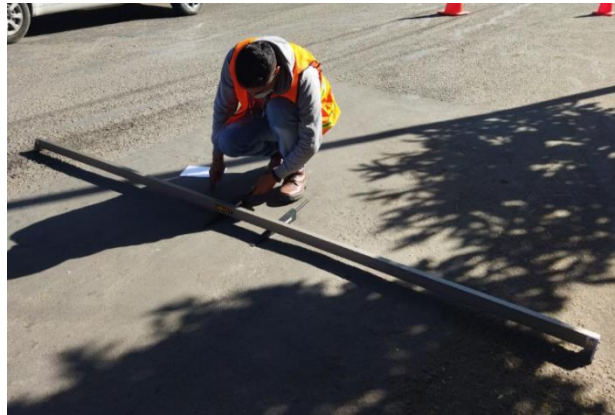
Figura A. 4 Colocado de la regla sobre el bache.
