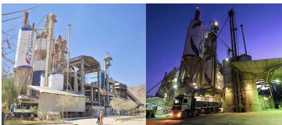
Figura 2.7: Planta de cemento El Puente-Tarija
