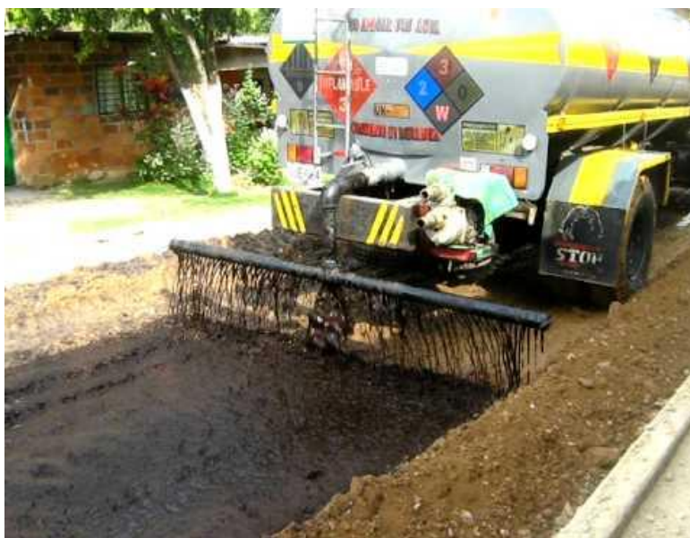
Figura 2.13: Estabilización química con asfalto
