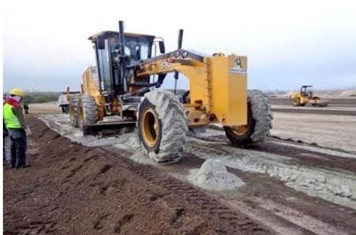
Figura 2.12: Estabilización química con cemento
