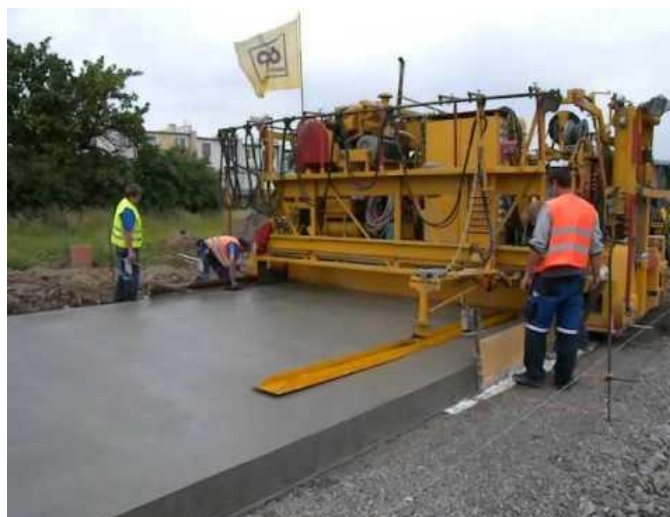
Figura 2.5: Losa de concreto
