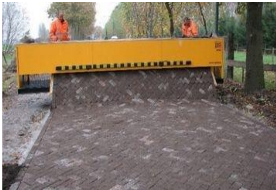
Figura 2.8: Capa de rodadura de adoquines de concreto
