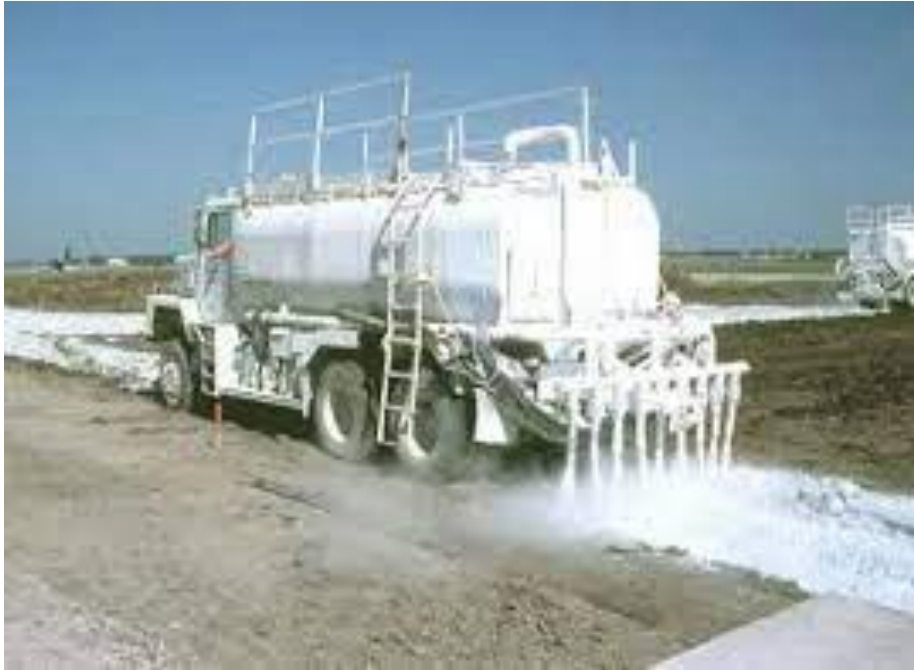
Figura 2.14: Estabilización química con sales
