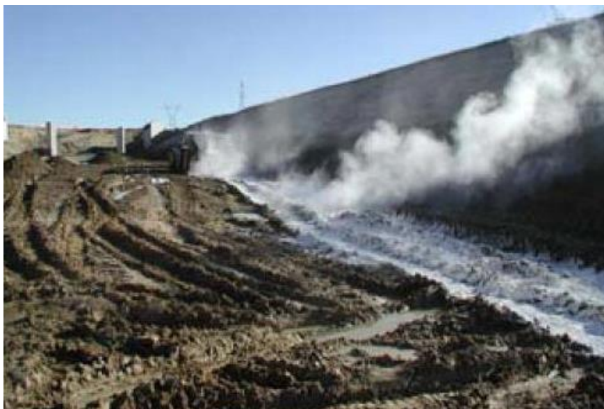
Figura 2.18: Evaporación producida en un suelo al extender cal
