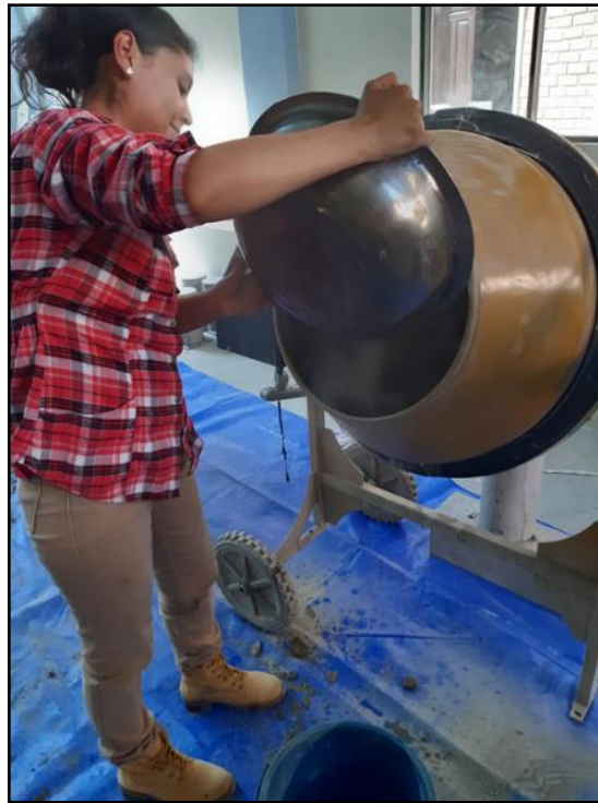
Fotografía 3.22 Mezclado del hormigón
