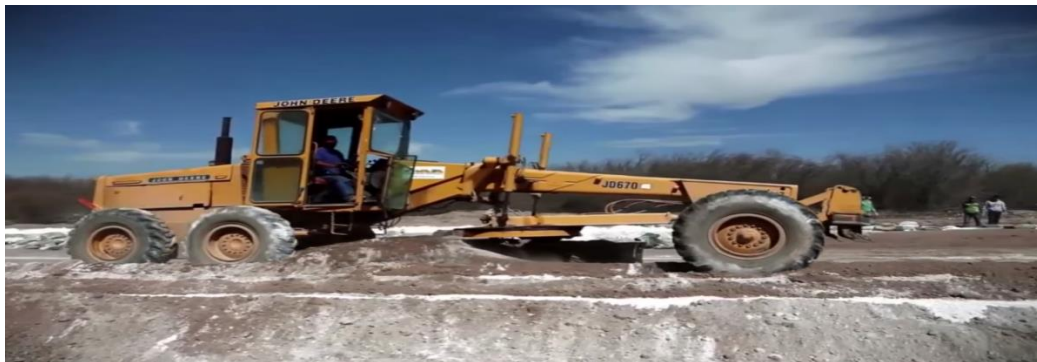
Figura 5. Estabilización de suelos arcillosos
