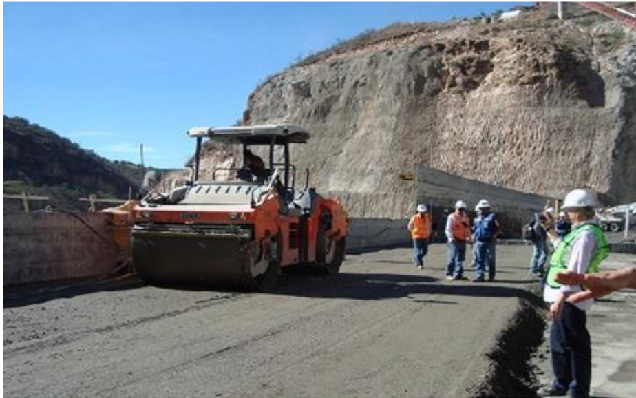
Figura 10. Compactación CCR con rodillo vibratorio
