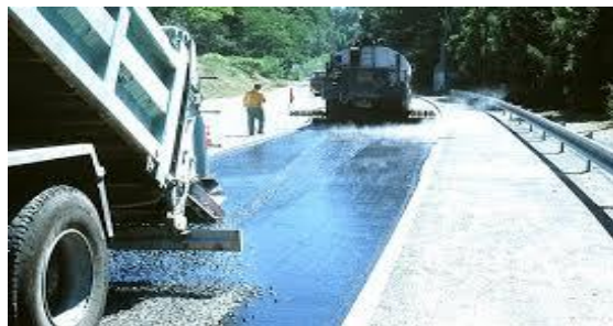
Figura 42 aplicación de capa de sello localizado
