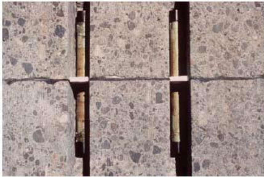
Figura 29 Colocado de pasadores
