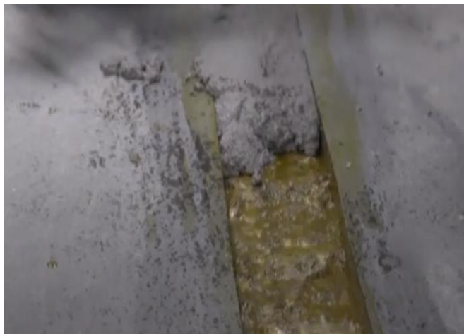
Figura 46 Reparación de junta
