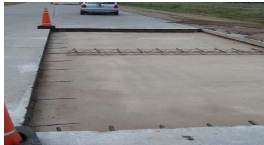
Figura 43 Reparación de todo el espesor
