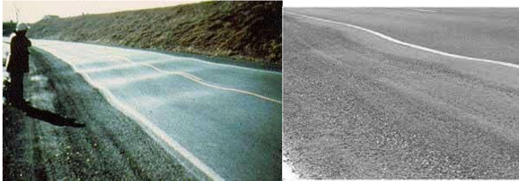
Figura 6 Hinchamiento en un pavimento
