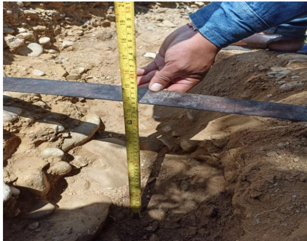
Figura 34 Espesor capa subbase
