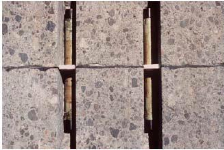
Figura 47 Reparación de junta
