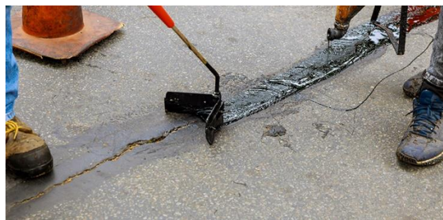
Figura 41 Aplicación de capa de sello localizado
