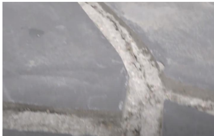
Figura 45 Reparación de junta
