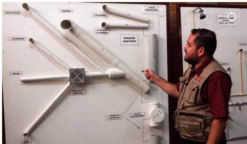
Figura 3.5. Croquis de un sistema de drenaje.
