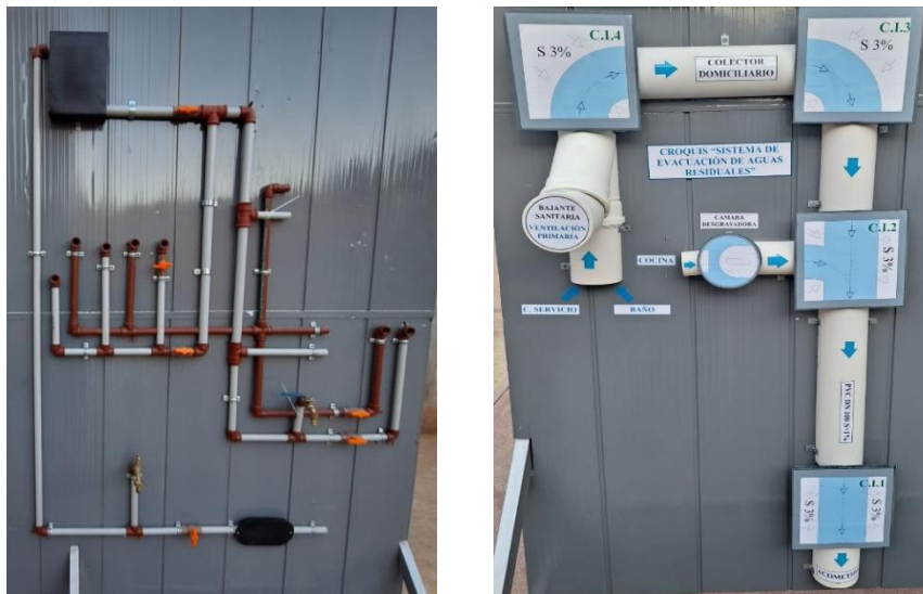
Figura 3.27. Croquis de instalaciones hidrosanitarias domiciliarias.
