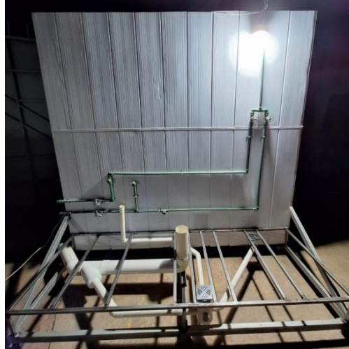
Figura 3.26. Instalación del sistema de evacuación de aguas residuales “Baño 1”.
