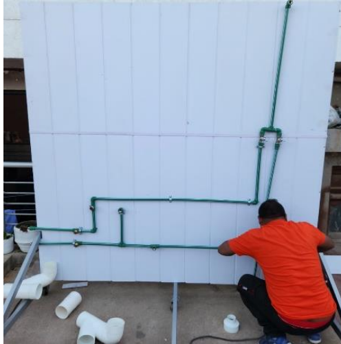
Figura 3.24. Instalación de las tuberías del baño.
