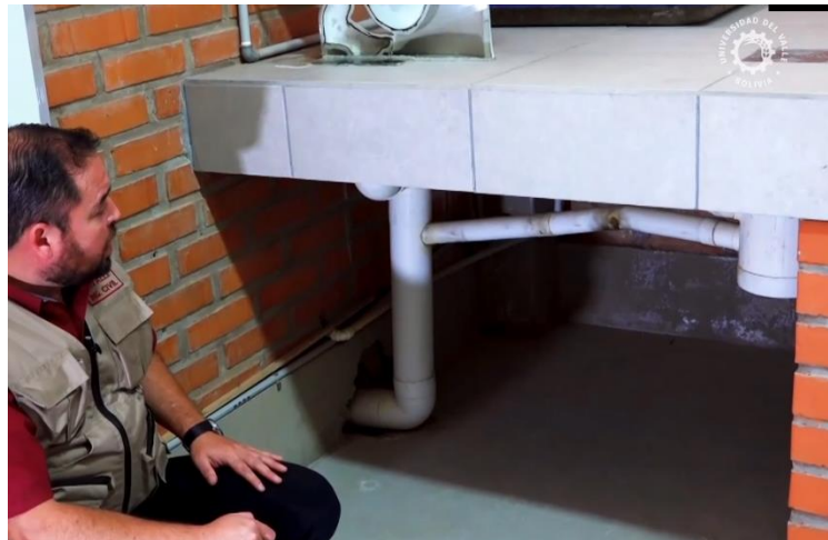
Figura 3.8. Instalación de la tubería drenaje.
