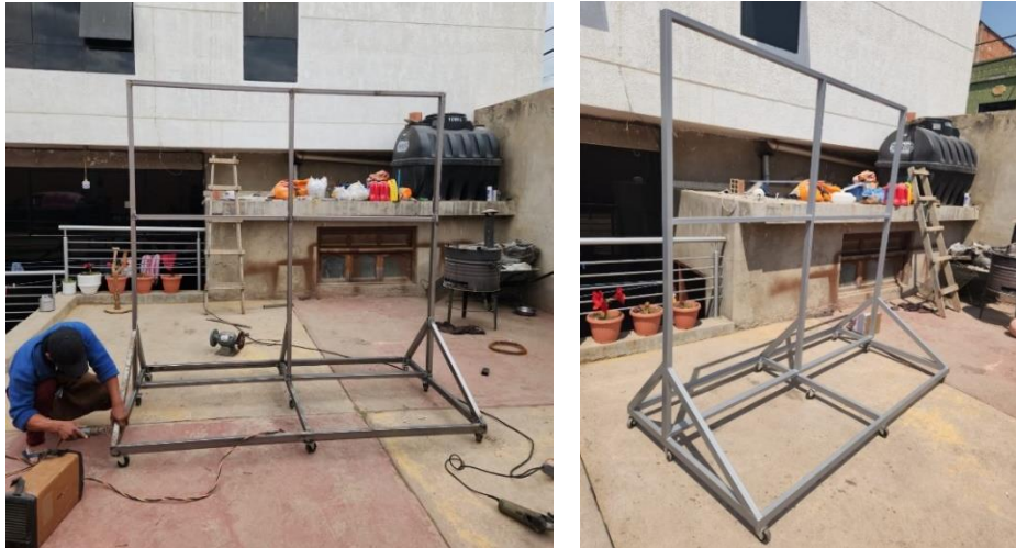
Figura 3.22. Construcción de estructura de metal.
