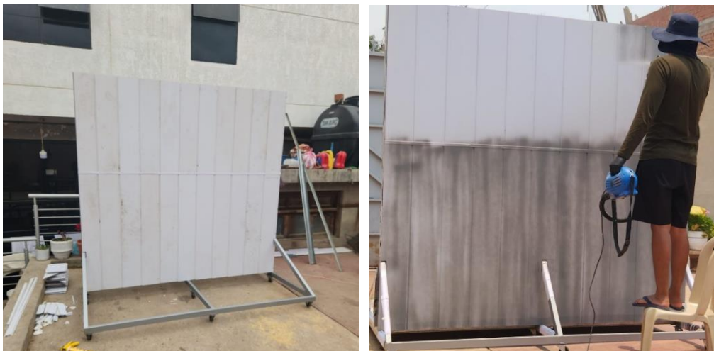
Figura 3.23. Colocado de placas PVC en la estructura de metal.
