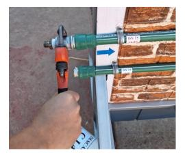
3) Conectar la manguera de la bomba de pruebas y ajustar.
