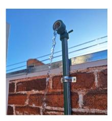
8) Una vez purgado todo el aire tapar el punto de agua más alto con un tapón macho ajustando con la lleve stilson para evitar fugas.
