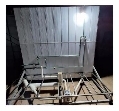
5. Revestimiento con papel placa autoadhesivo al muro de PVC
