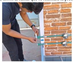
2) Conectar la cupla metálica al ramal de agua y ajustar con la llave stilson para
