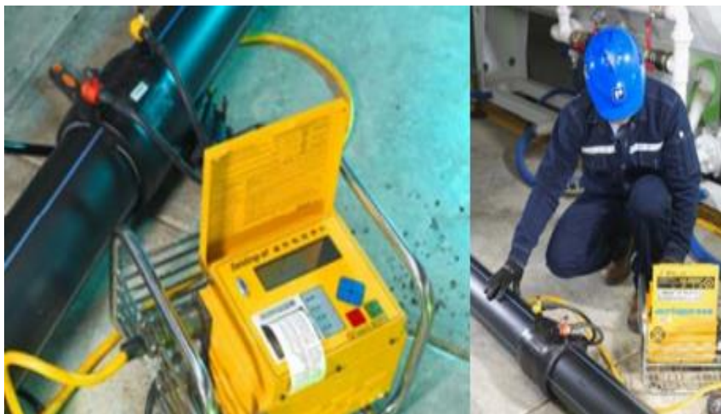
Figura 5. Unión por electrofusión.
