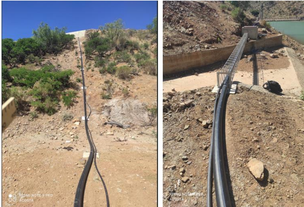
Figura 11 Tubería PEAD a la intemperie proyecto micro riego en la presa la Viscacha-Tarija Fuente: Fotografías del autor tomada 1/05/2022
