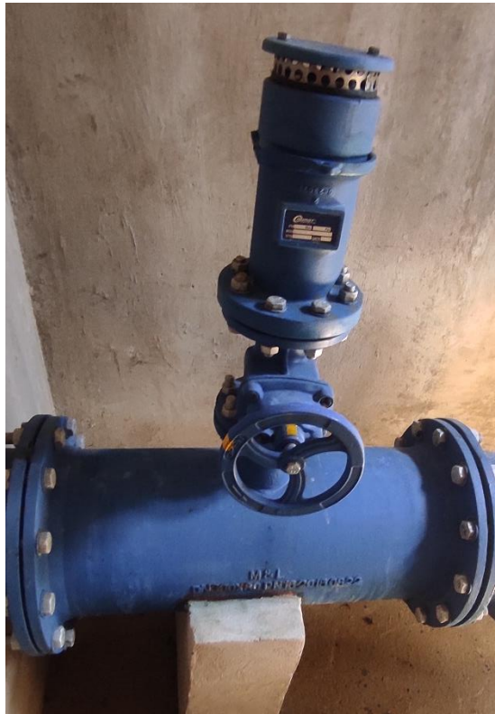
Figura 3 Purgador de aire de una estación reductora de presión de 12 pulgadas Fuente: Fotografías del autor tomada 7/12/2022
