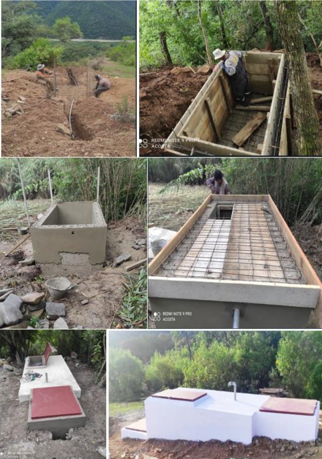
Figura 13 Detalles del proceso constructivo de cámara rompe presión. Proyecto de agua potable Padcaya-Tarija Fuente: Fotografías del autor tomada 06/2022
