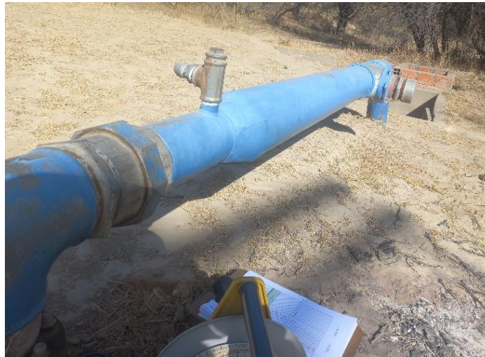
Figura 88 Tubería de desagüe clausurado
