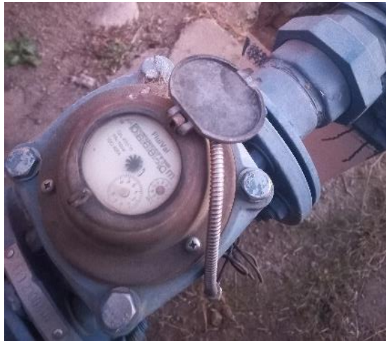
Figura 71 Aforo del caudal de bombeo
