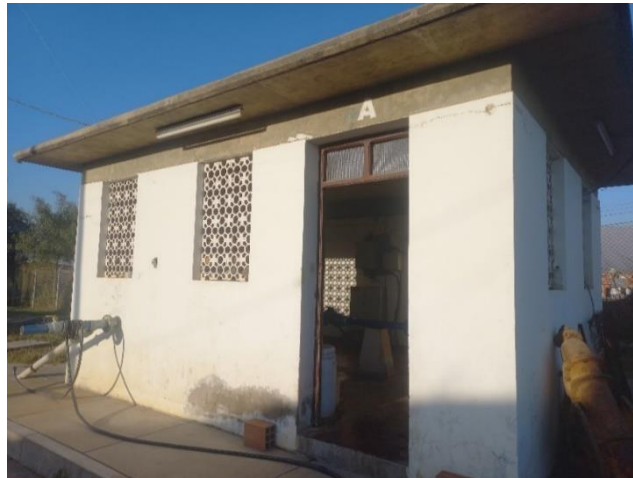
Figura 102 Pozo AVIT A
