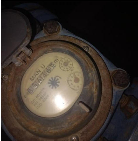
Figura 77 Aforo del caudal de bombeo
