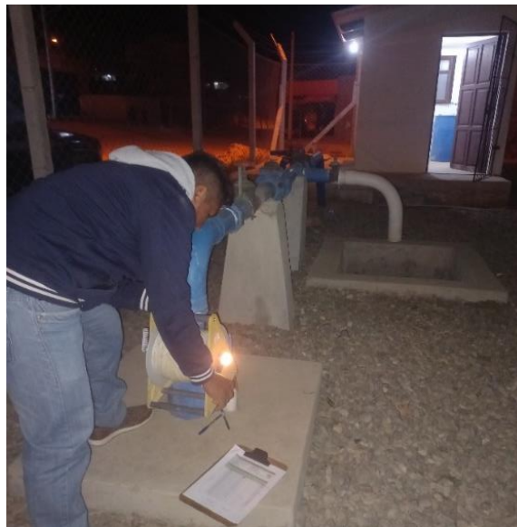
Figura 76 Medición de la recuperación, pozo San Jorge I (PN)
