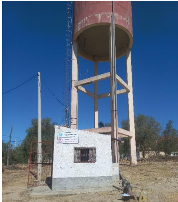
Figura 51 Pozo de agua San Jorge II
