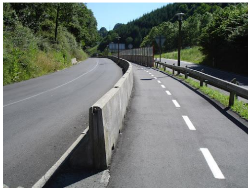
Imagen 2.9 Barreras de contención de hormigón
