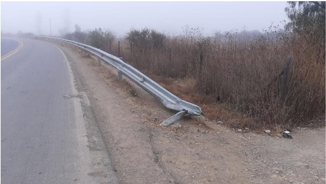
FOTOGRAFIA 10: Barreras después de un accidente
