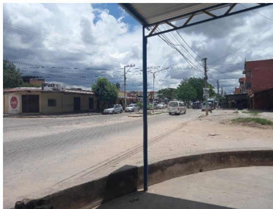
Figura 4.2 Falta de señalamiento horizontal intersección 19
