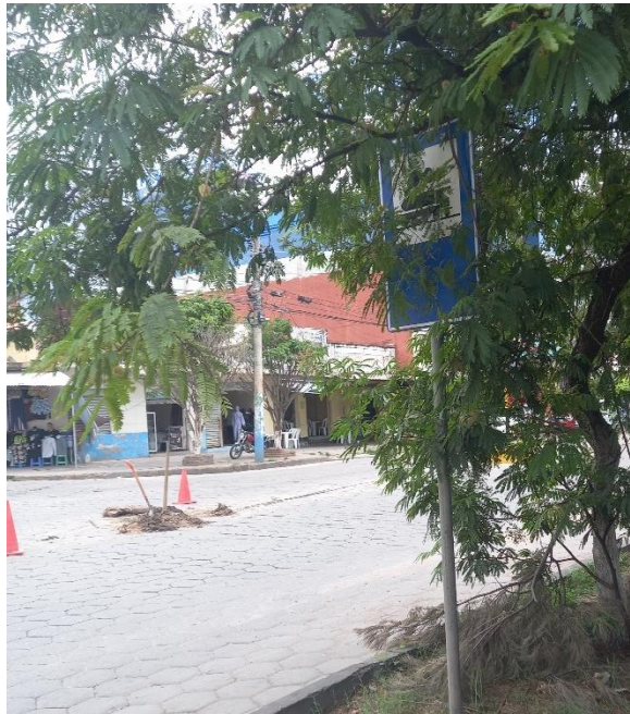
Figura 4.7 Señalización vertical obstruida visualmente para el conductor, intersección 10
