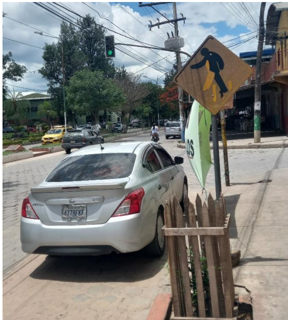
Figura 4.5 señalización vertical con deficiencias en la figura intersección 11
