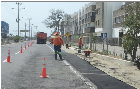
Figura 3.53 Renivelación de bermas
