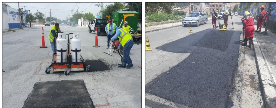
Figura 3.54 Bacheos con mezclas finas
