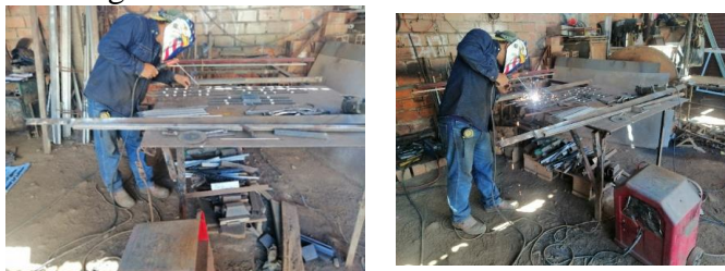
Fotografía 4.9: Proceso de Soldadura
