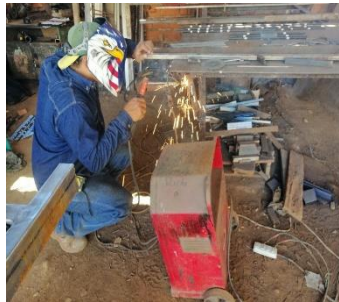
Fotografía 4.8: Testeo de Corriente
