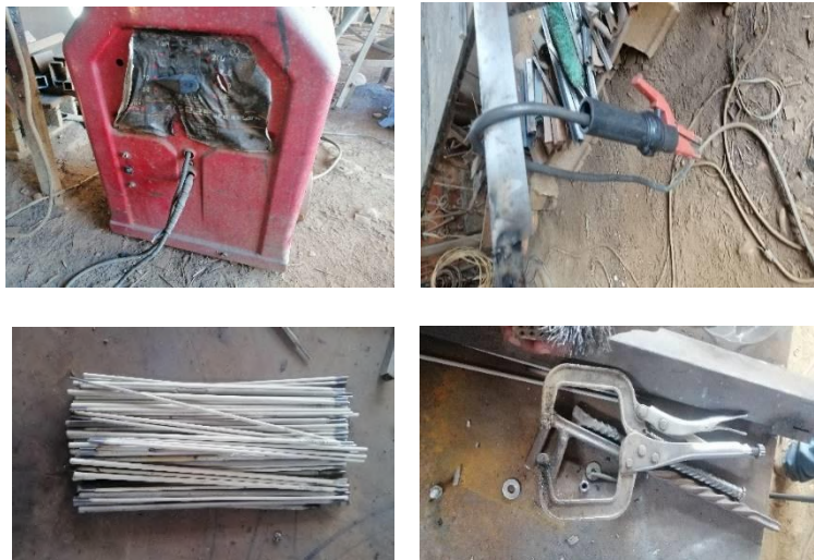
Fotografía 4.6: Equipo usado en Soldadura
