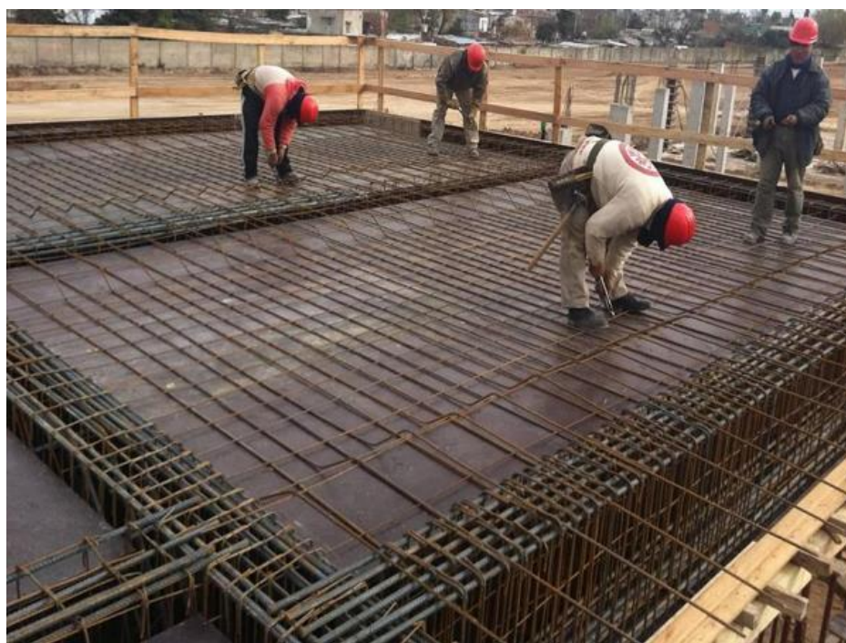
Figura 2.8. Armado de losa maciza de hormigón armado.
