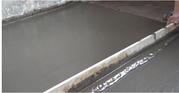
(Carpeta de nivelación con impermeabilizante y microfibras sintéticas.)
