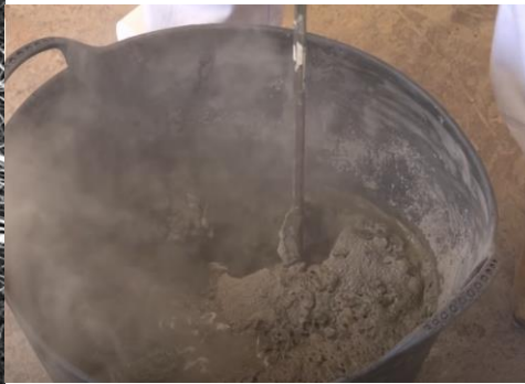
(Mortero con impermeabilizante)
