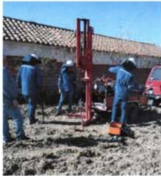
Ensayo S.P.T. y extracción de muestra
