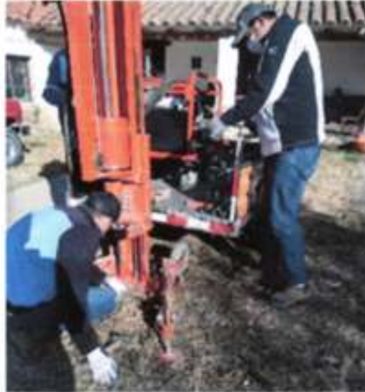
Ensayo S.P.T. y extracción de muestra
