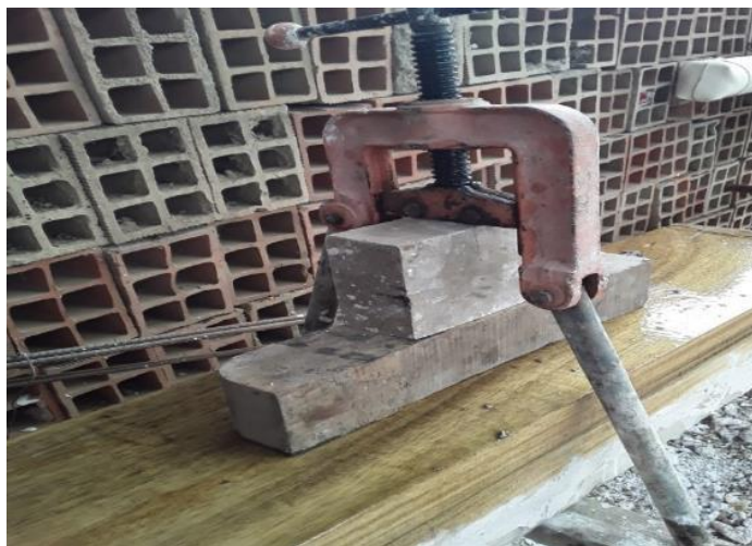
Fotografía 3.7. Prensa mecánica armada y colocada en el sitio
