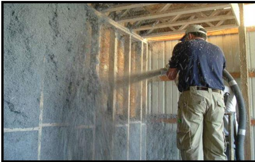
Figura: 2.2. Aislante térmico y acústico de celulosa proyectado
