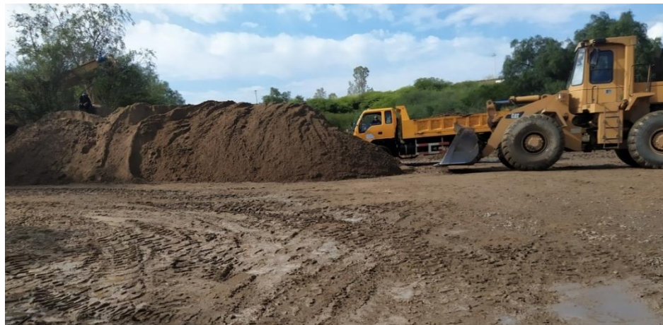
Recolección de agregado fino de banco de Santa Ana.
