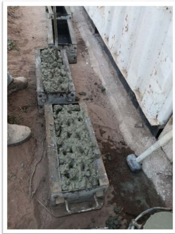
Figura 23 Elaboración de Vigas de Concreto (Fuente: Elaboración Propia)
