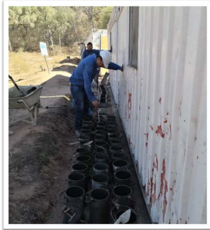
Figura 22 Elaboración de Cilindros de Concreto (Fuente: Elaboración Propia)
