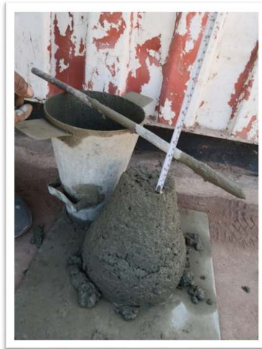
Anexo 12 Control de Asentamiento Del Hormigón Mediante El Cono de Abrams (Fuente: Elaboración Propia)
