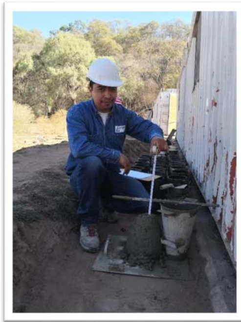
Anexo 13 Control de Asentamiento del Hormigón Mediante el Cono de Abrams (Fuente: Elaboración Propia)
