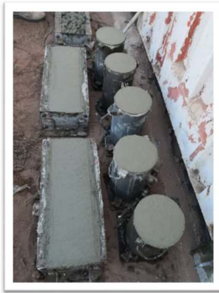
Anexo 19 Moldeo de Vigas (Fuente: Elaboración Propia)
