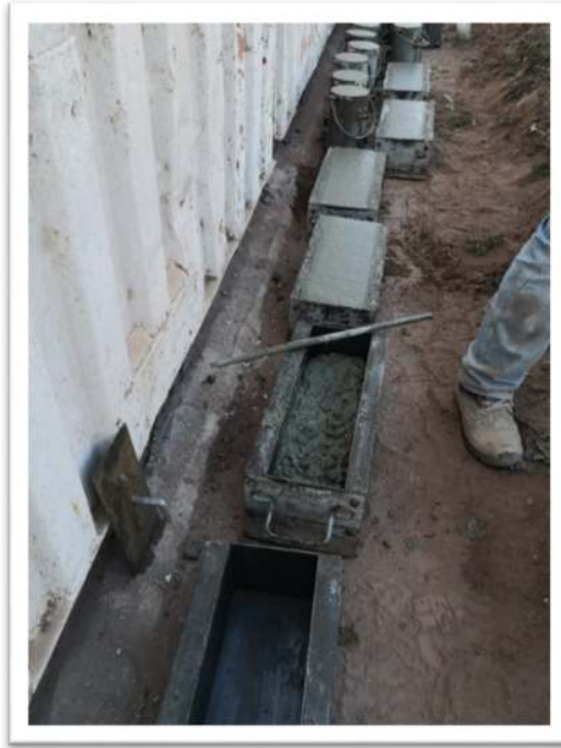
Moldeo de Vigas (Fuente: Elaboración Propia)
