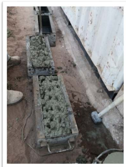
Moldeo de Vigas (Fuente: Elaboración Propia)
