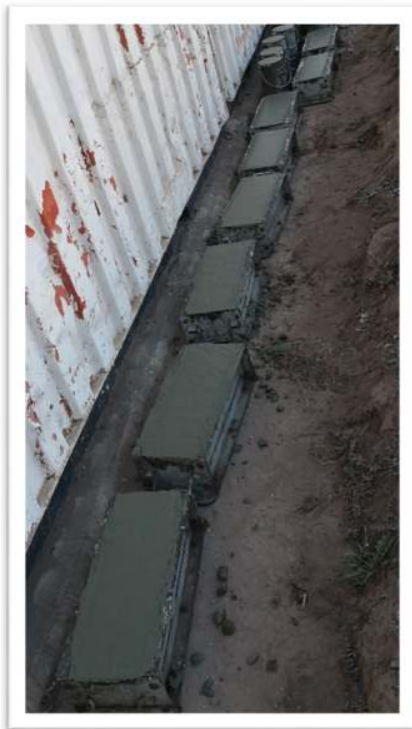
Anexo 20 Moldeo de Vigas (Fuente: Elaboración Propia)
