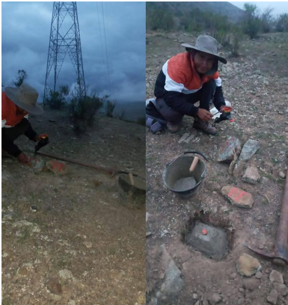
Imagen N° 4. Colocado de nombre y vaciado de los BM
