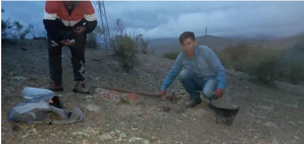
Imagen N° 3. Vaciado del BM6 con hormigón ciclópeo
