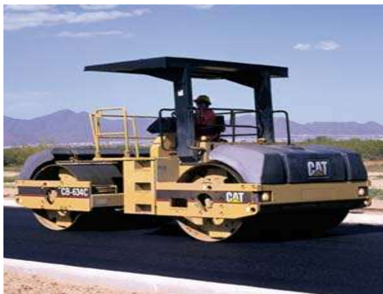
Figura N°2.3 Proceso de compactación in situ
