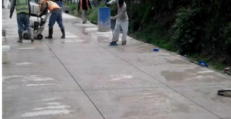
Figura 2.8. Curado del pavimento ultradelgado
