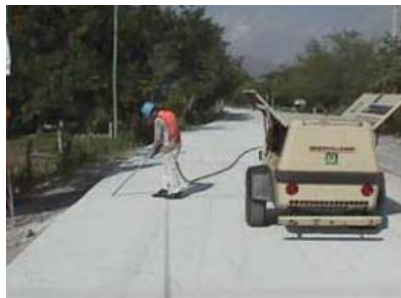
Figura 2.18. Obrero realizando el sellado de un pavimento
