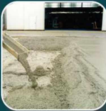
Pisos y pavimentos
