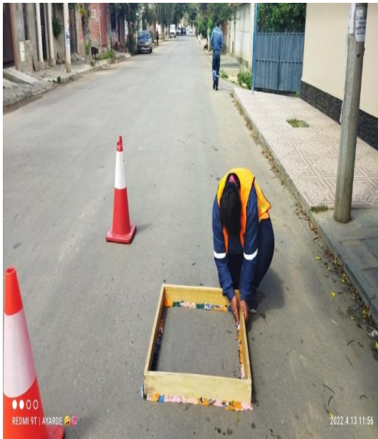
Figura. 3.11. Colocado del sellado del contenedor con plastilina.
