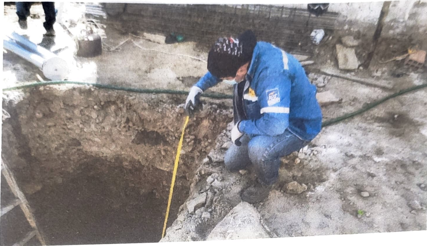
MEDICIÓN DE PROFUNDIDAD DE CALICATA
