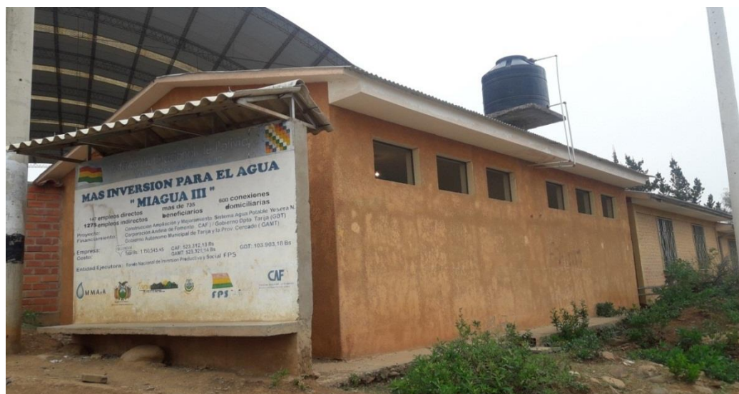
Figura 2- 8: Vista de los sanitarios desde la calle - Unidad Educativa Yesera Norte
