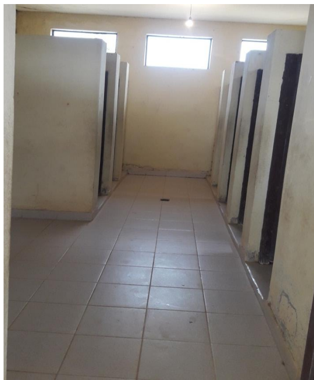
Figura 2- 7: Vista de los sanitarios - Unidad Educativa Yesera Norte
