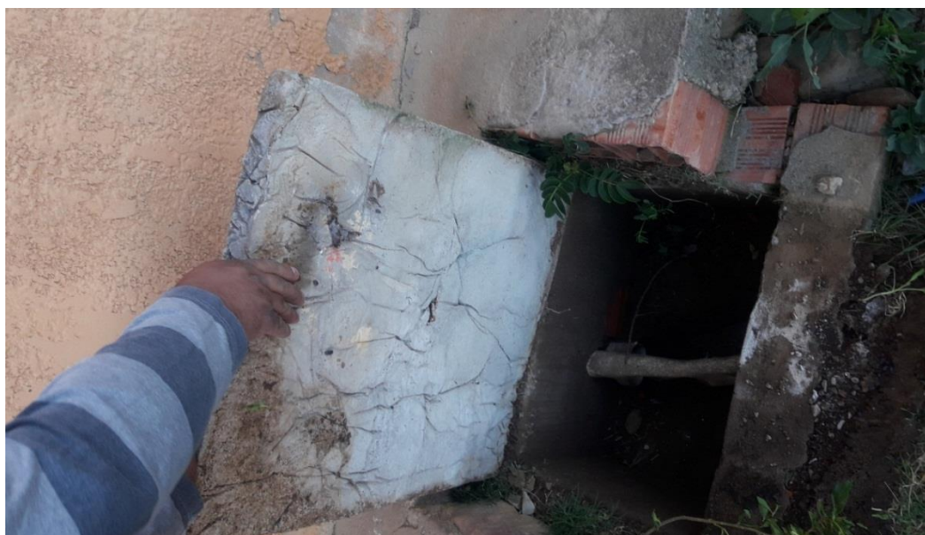
Figura 2- 10: Cámara de inspección salida de los sanitarios de mujeres-Unidad Educativa Yesera Norte
