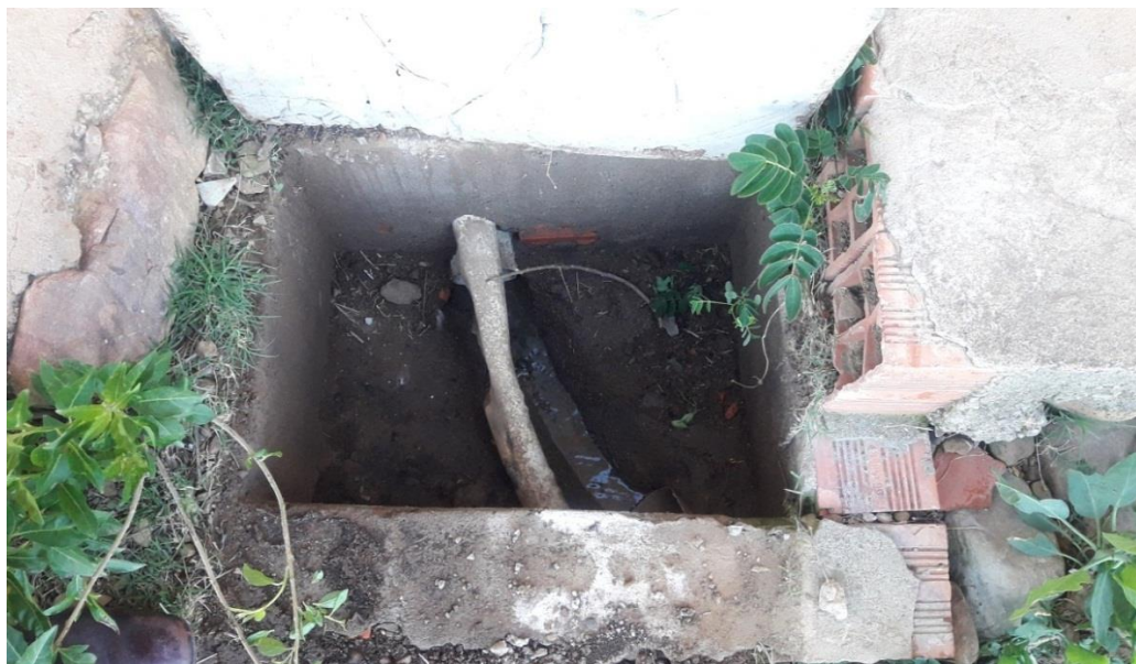
Figura 2- 11: Cámara de inspección salida de sanitarios de mujeres-Unidad Educativa Yesera Norte
