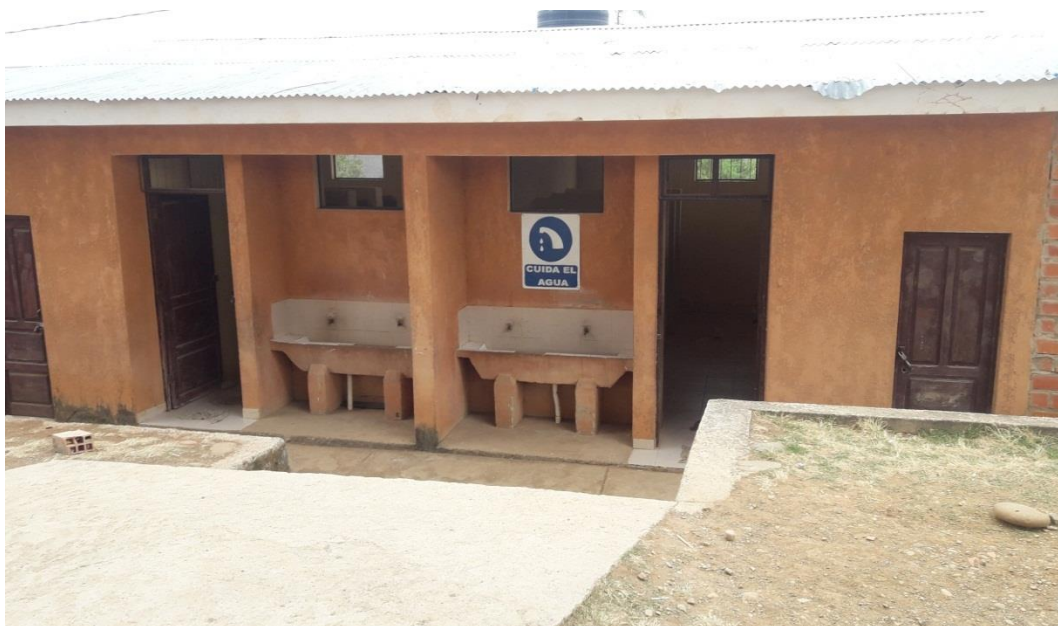
Figura 2- 5: Vista de los sanitarios - Unidad Educativa Yesera Norte
