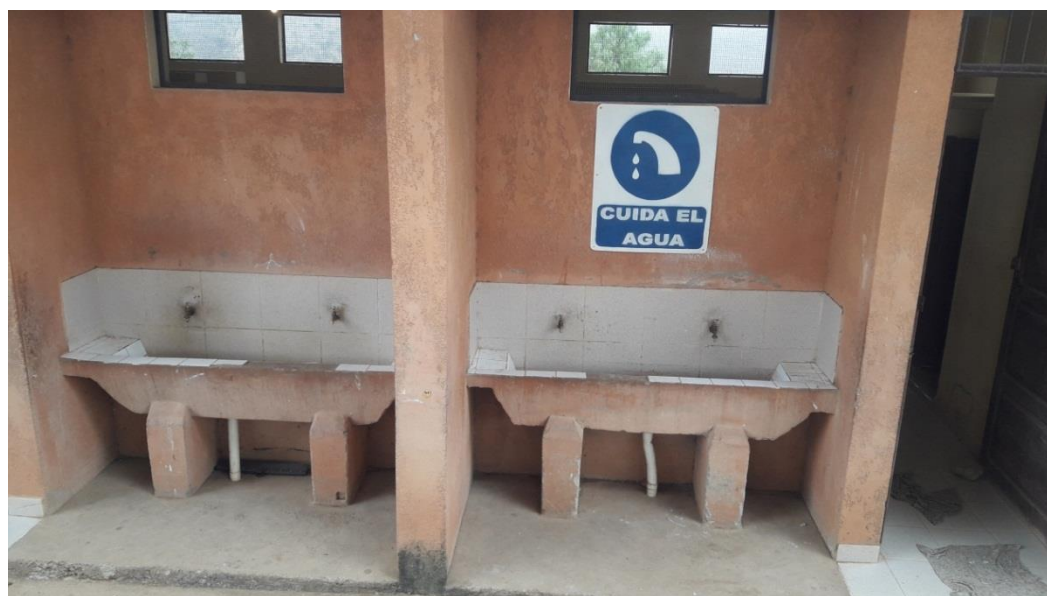
Figura 2- 6: Vista de los lavamanos - Unidad Educativa Yesera Norte
