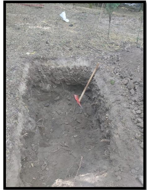
Fotografía N° 18 y 19 Excavación de las calicatas para el levantamiento de información de las características internas suelo
