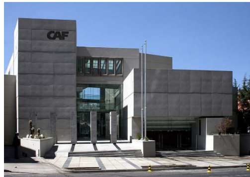
FIG.16 Edificio de la corporación andina
