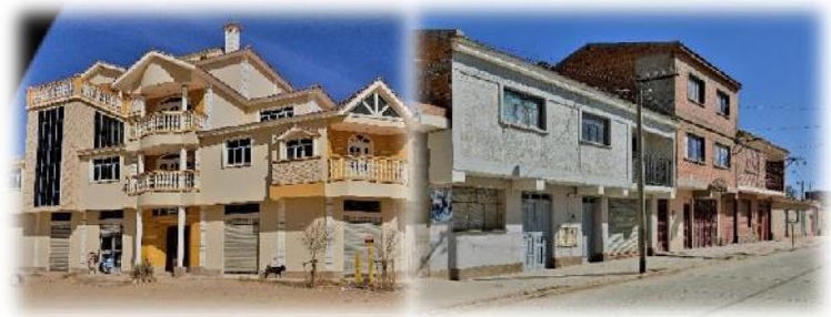
Figura N° 29: Imagen propia viviendas multifamiliares
