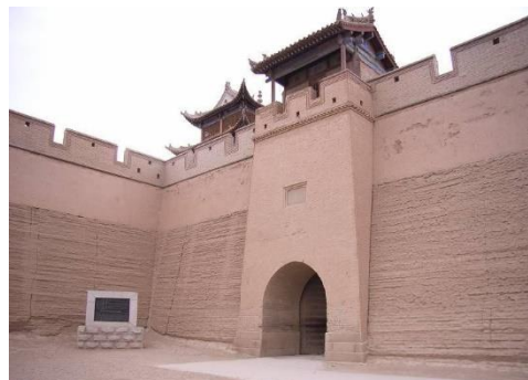
Muralla en tapia pisada y ladrillo de barro en Juayuguan, China.
