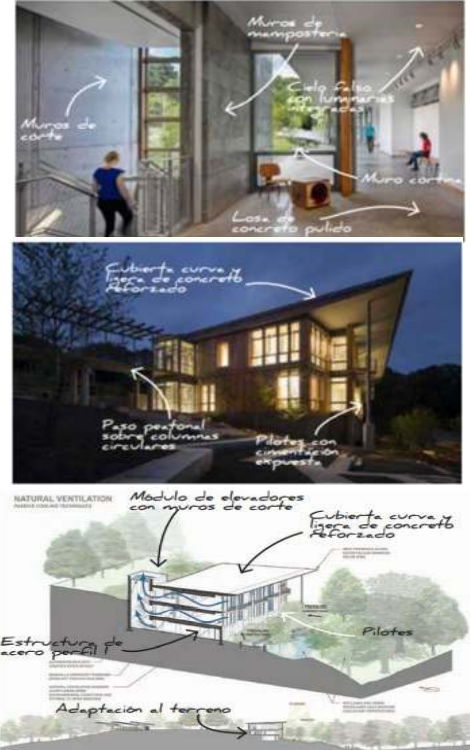
FIGURA 26: Tecnologías implementadas en el edificio
