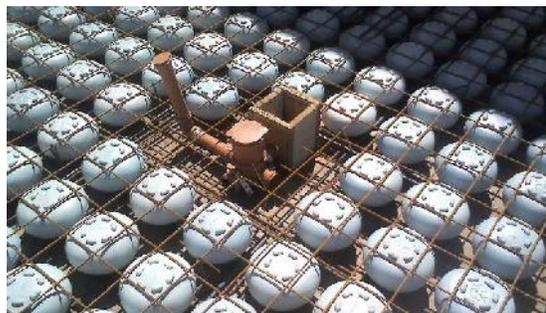
El comportamiento estructural y el método de cálculo usado para las losas Prenova es idéntico al de una losa maciza. Está comprobada, por pruebas de carga in situ (ver informe ITH), una mayor resistencia a la flexión y deformación comparada a las losas macizas, debido a la reducción del peso propio.
