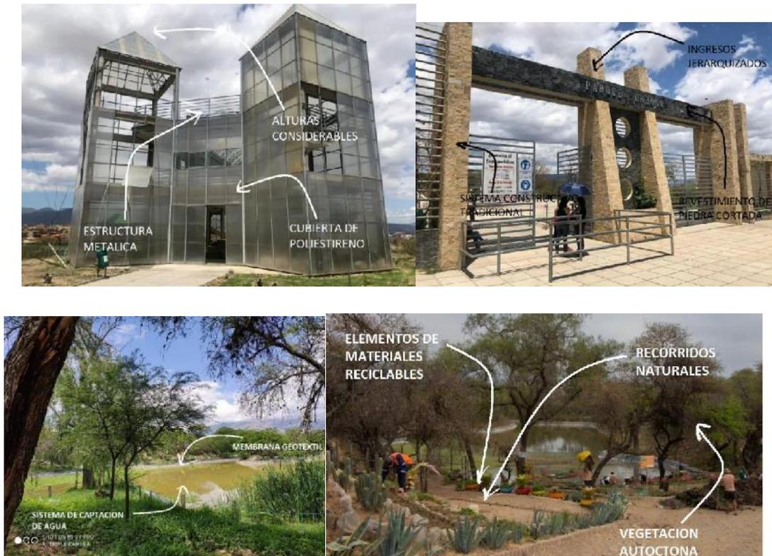
Se aplican diferentes materiales, para los recorridos se utiliza muy poco concreto, principalmente en la zona del atrio y el ingreso principal; sus construcciones son de sistema tradicional, para elementos más montables se utiliza estructuras metálicas, y también tiene sistemas sostenibles como captación de agua, se usan también algunos mobiliarios de materiales reciclables.
