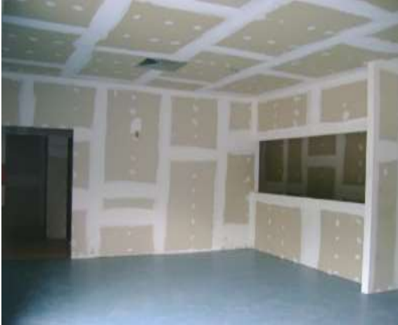
MUROS EN SECO
