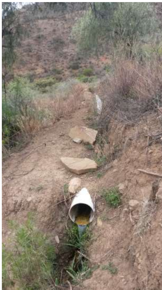
Imagen N° 10: mejoramiento de canales de tierra con tubería, para las familias que si contaban con el riego permanente.
