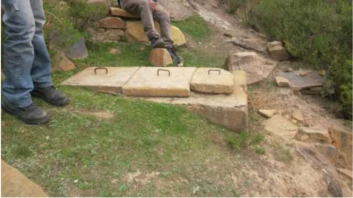
Imagen N° 13: construcción de una toma de agua para riego, desde la vertiente en la serranía, perteneciente a las dos familias de la zona 1
