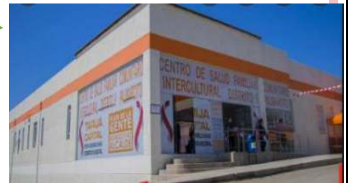
CENTRO DE SALUD EN CONSTRUCTOR
