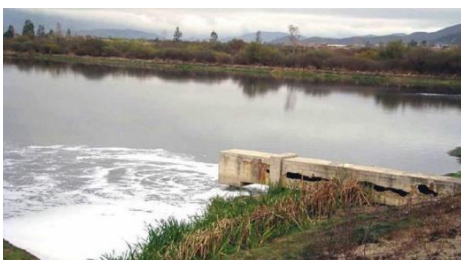
Lagunas de oxidación, google, 2022
