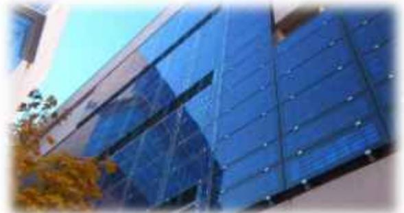
Figura 41 Ventanas Solares
