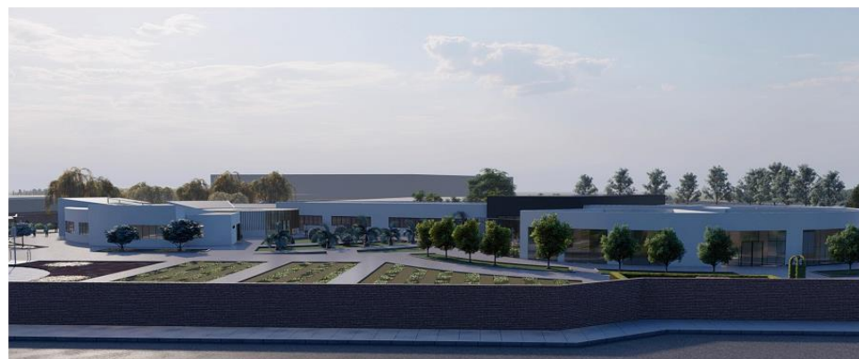
FACHADA LATERAL IZQUIERDA
