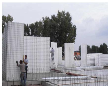
El corazón del sistema es el panel simple poliestireno expandido, encerrado entre dos mallas de acero galvanizado unidas entre sí por conectores que se completa en la obra con capas de mortero cementico proyectado.
