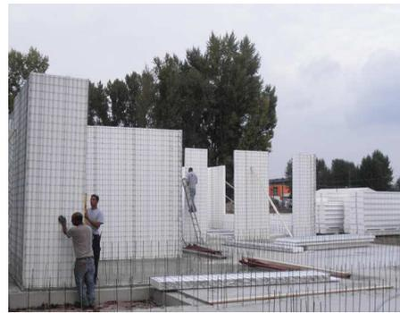
El corazón del sistema es el panel simple poliestireno expandido, encerrado entre dos mallas de acero galvanizado unidas entre sí por conectores que se completa en la obra con capas de mortero cementico proyectado.
