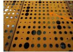
La Fachada utilizada en todo en base a paneles tipo "Screen Panel" de Acero Corten perforado.
