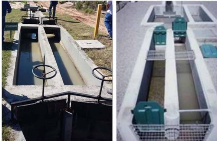
Figura 14. Canales desarenadores de flujo variable.
