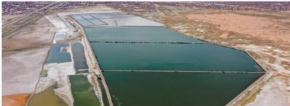
Figura 28. Lagunas de Estabilización (PTAR Oruro, Bolivia).
