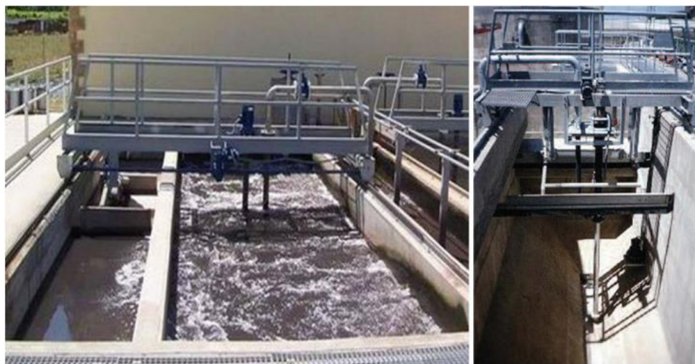
Figura 23. Desarenadores-desengrasadores aireados.
