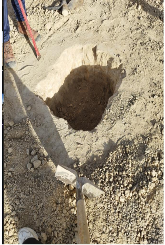
Excavación de calicatas.
