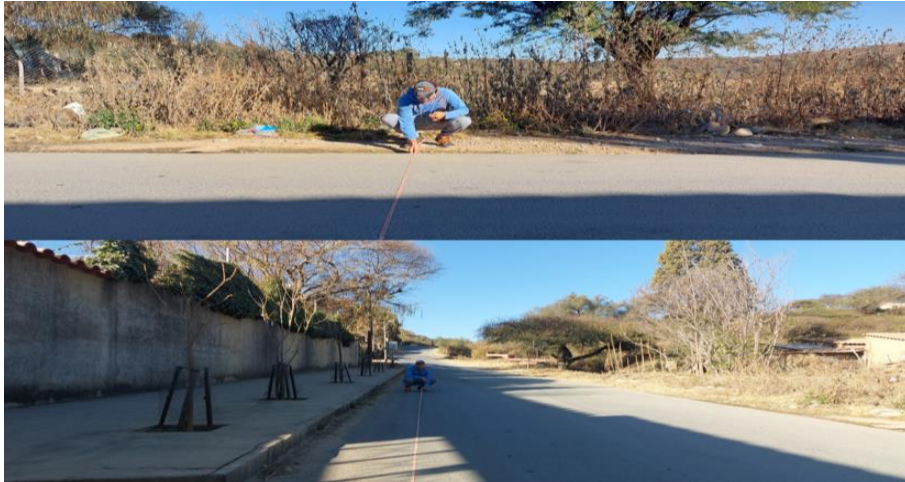
Figura 3.5 Medición de la zona asfaltada (Obrajes)
