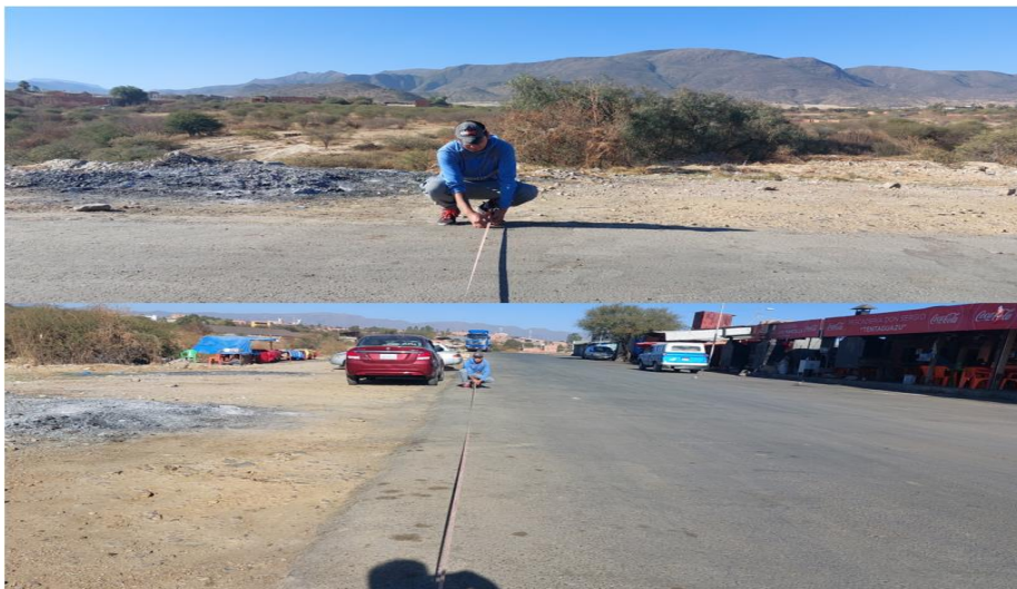
Figura 3.7. Medición de la zona asfaltada (Abasto del Sur)
