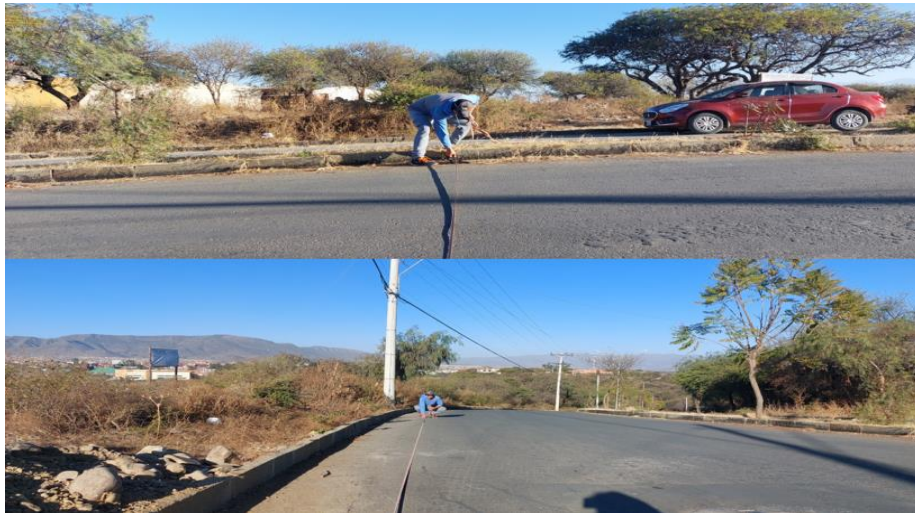
Figura 3.13 Medición de la zona asfaltada (Aranjuez)
